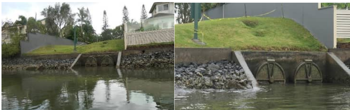
SR-12: 5325 Marine Dve Nth– apparent subsurface pipe breaches
